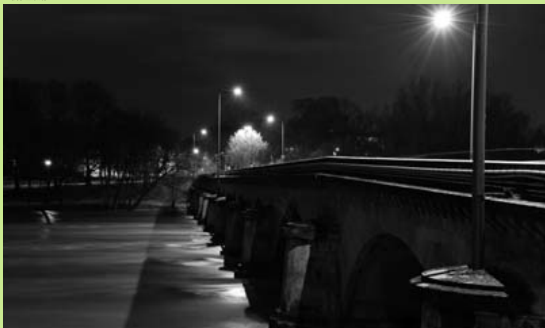
Pont des morts
